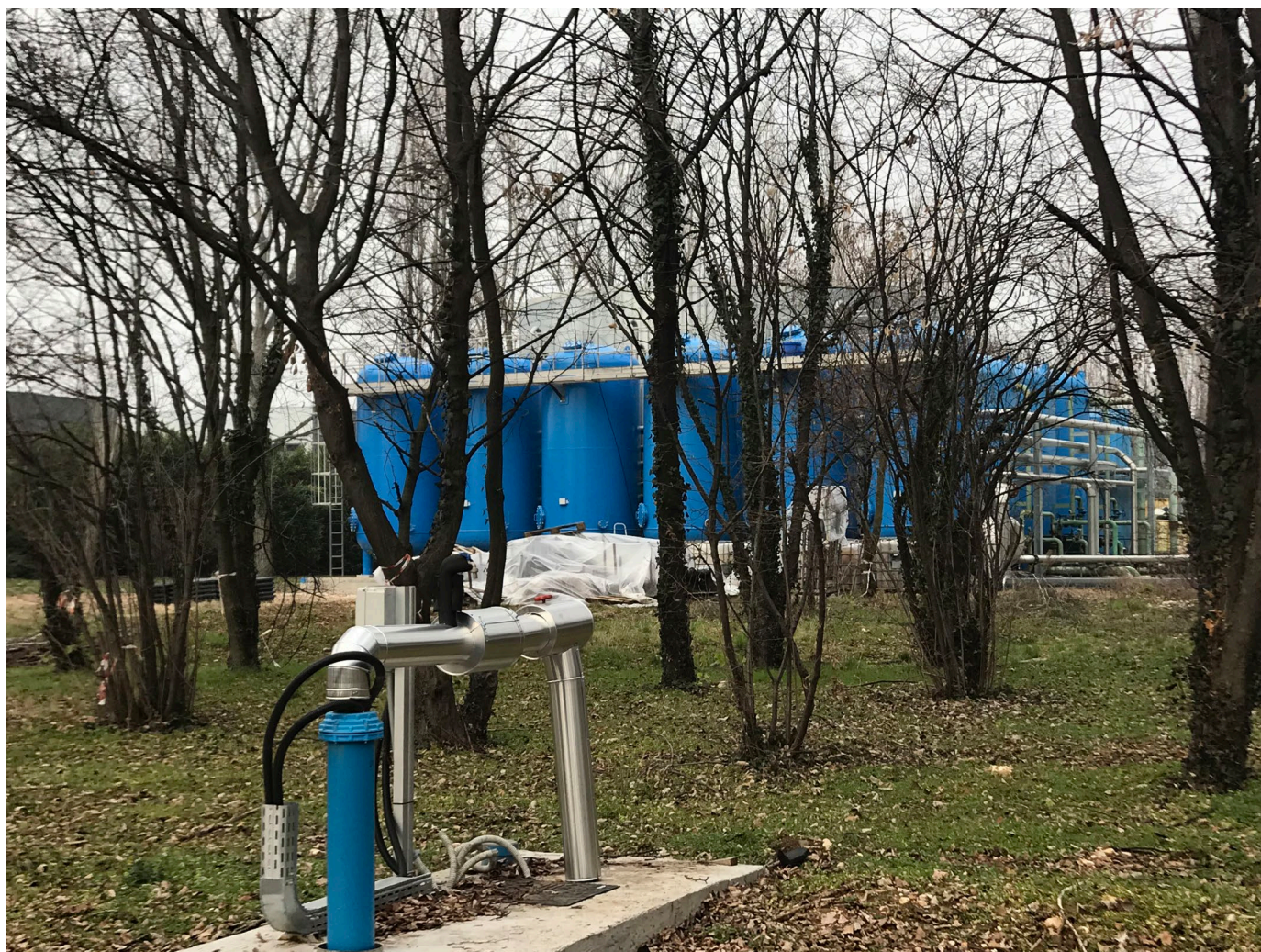
Sistema di pompaggio e filtraggio dei-Pfas in Mitenei.jpeg
